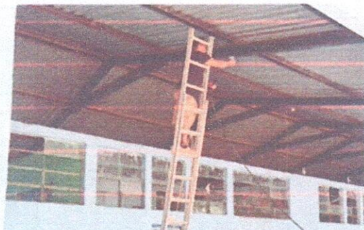
Foto 5: Cambio de plafoneras de los modulos
