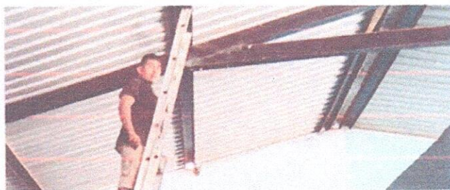
Foto 4: Cambio de cables en los modulos
